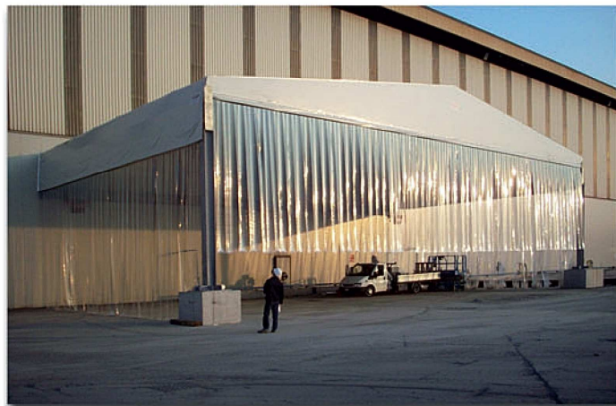
Esempi di chiusura scorrevole per ambiente interno e per ambiente esterno con strisce in PVC trasparente.
